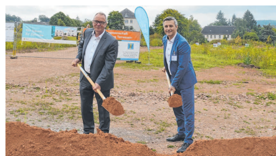
Jürgen Dixius (l.) und Ingo Schilling: Spatenstich auf dem Gelände der ehemaligen Kasernengelände. Foto: Kreller
