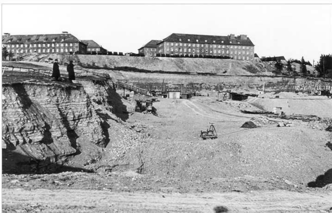
Der Steinbruch, wo Häftlinge unter schwersten Bedingungen arbeiten mussten, und die Kasernen der Waffen-SS.
